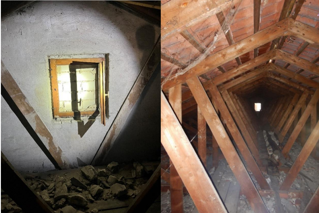
Abbildung 3.2-5: Dachstuhl des nördlichen Garagenkomplexes
