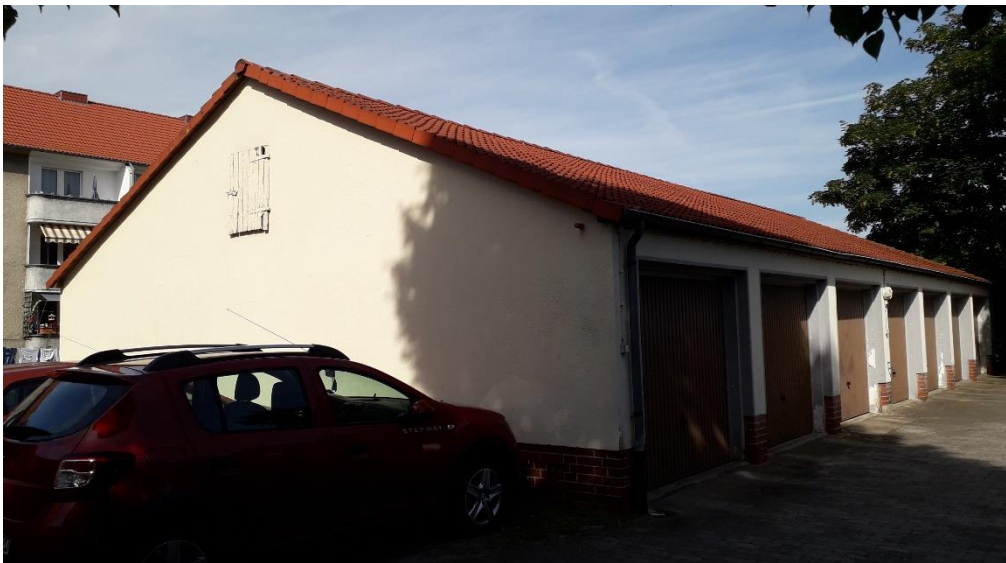
Abbildung 2.2-2: Nördlicher Garagenkomplex mit flachem Spitzdach
