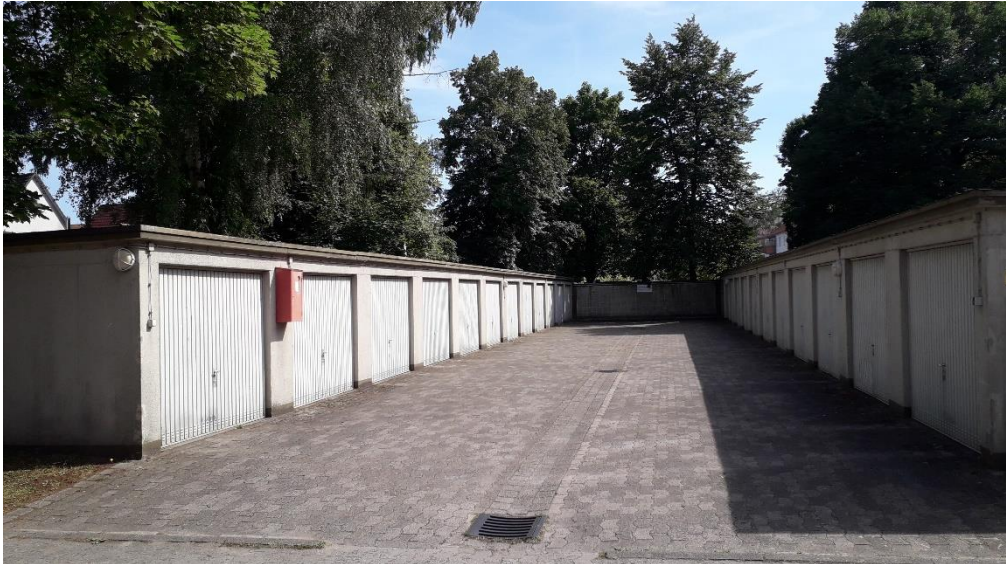
Abbildung 2.2-1: Parallele Garagenkomplexe im Süden des Plangebiets
